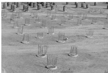
图5 桩头破除效果
